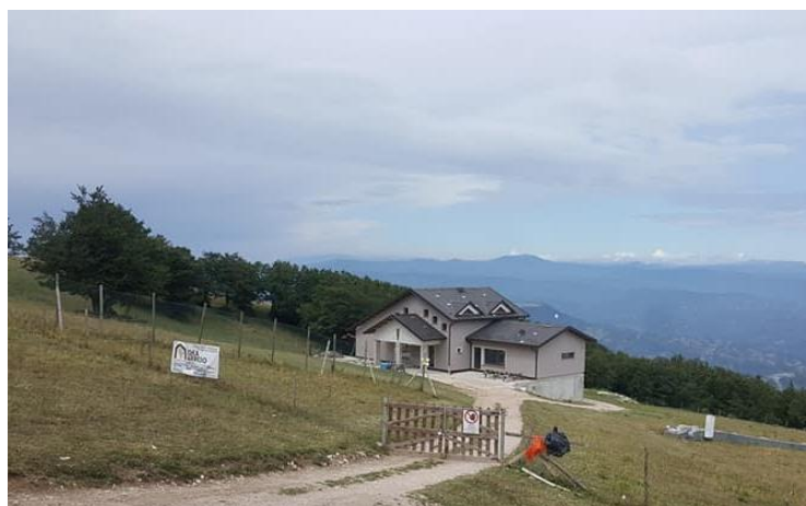
Il Rifugio Corsini, durante il periodo di ristrutturazione
